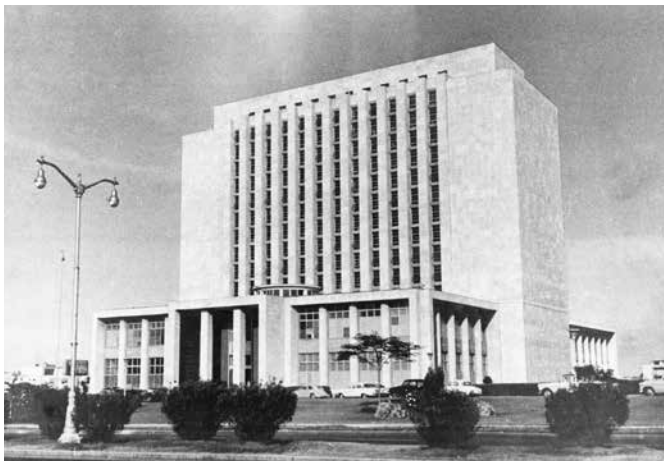
Edificio de la Biblioteca Nacional José Martí.
